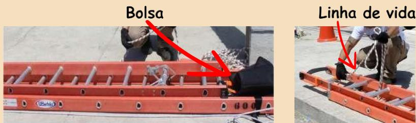
Fig. 08/09 - Instalação da bolsa p/ corda e da linha de vida. Fonte: Arquivo pessoal
