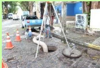
Fig. 11 - Ventilação geral diluidora com o conjunto ventilador centrífugo e mangote flexível.
