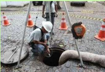
Fig. 09 - Avaliação da atmosfera interior com multigás.
